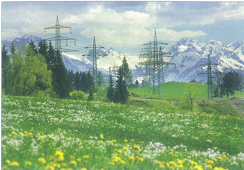
Das Stromnetz im Allgäu
